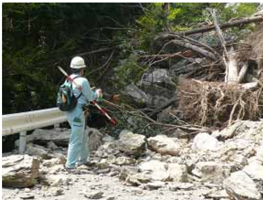
崩壊の幅をテープで測定
