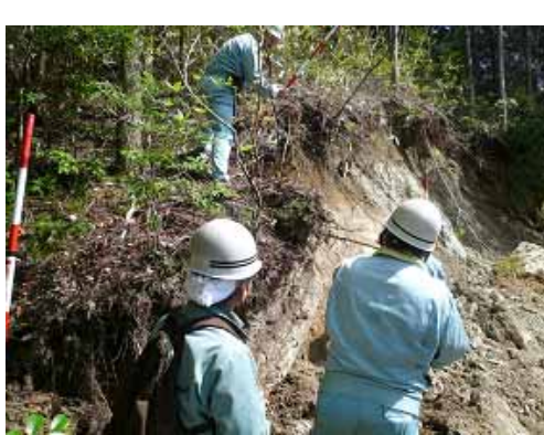
崩壊地頭部の滑落崖の調査
