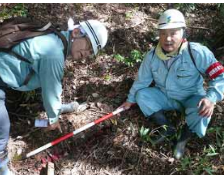
滑落崖の上の亀裂を調査
