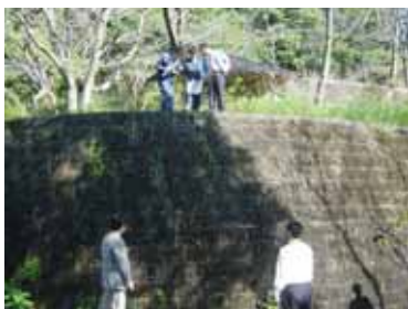
現地調査の様子
