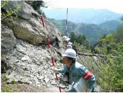
法面の吹付コンクリート，法枠の変状調査
