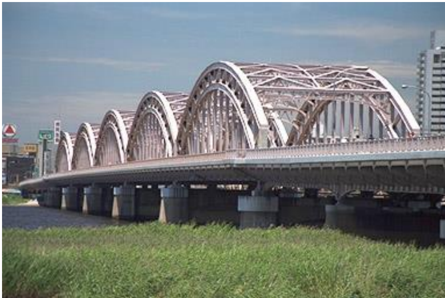
兵庫県西宮市武庫大橋
