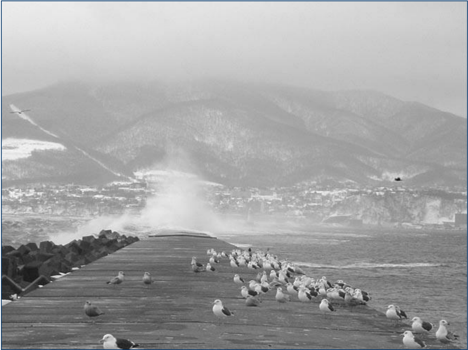
冬の季節風による強烈な波を遮る小樽防波堤
