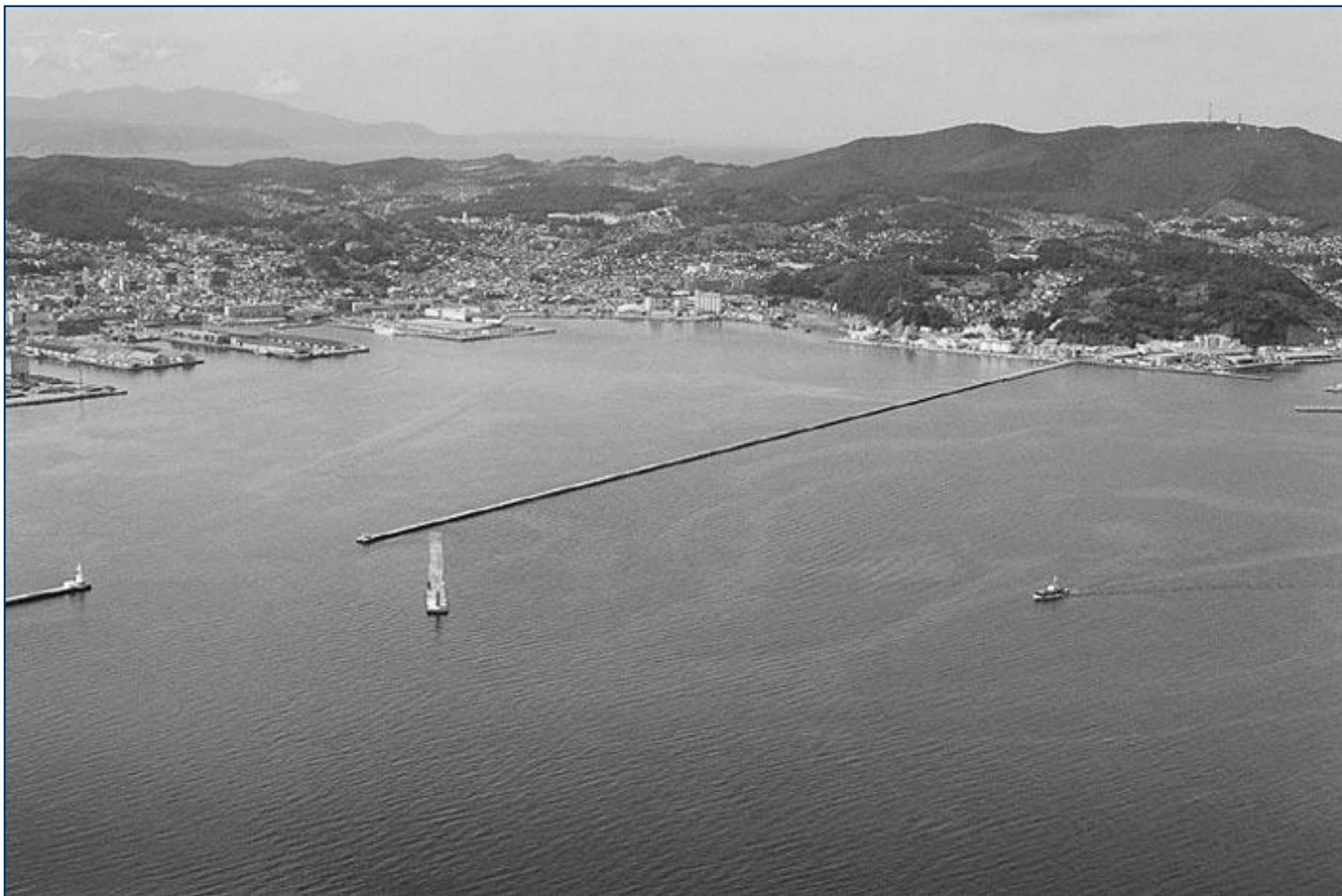
11年の歳月をかけて完成した小樽港北防波堤
